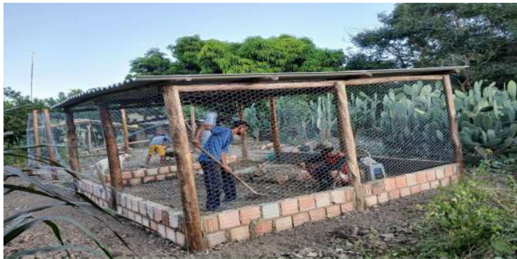
Construção dos Galinheiros.
