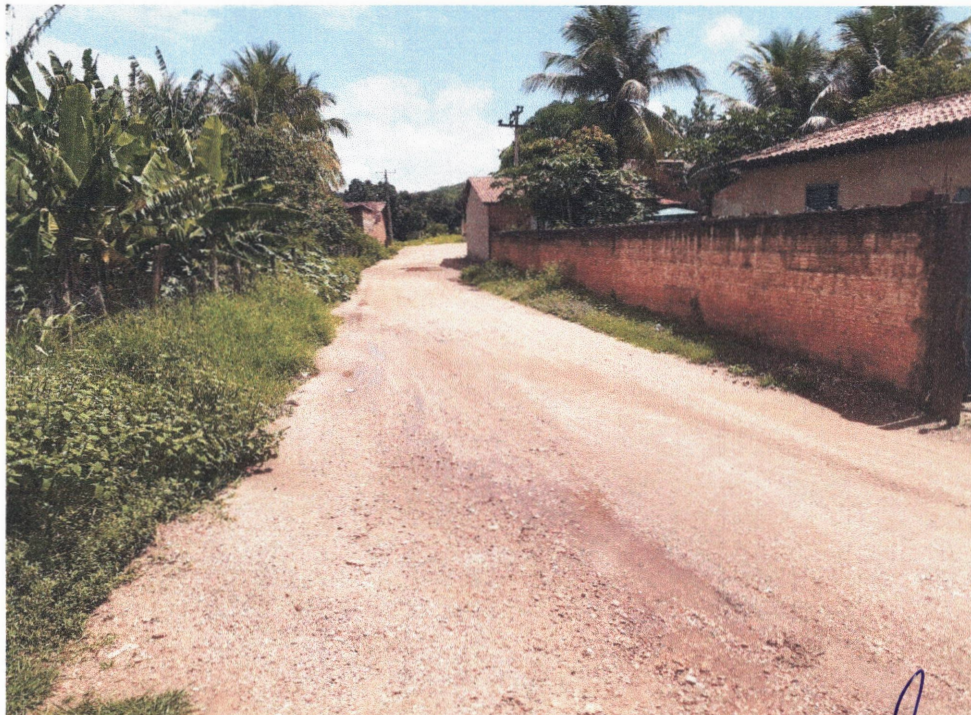
FOTO 11 – RUA SEGUNDA TRAVESSA
